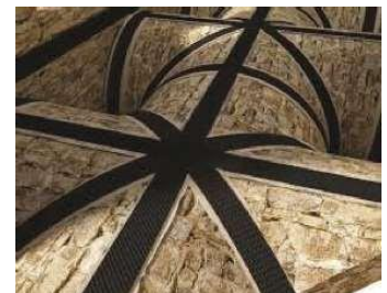
TONOZ GÜÇLENDİRME UYGULAMASI
